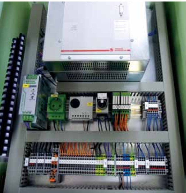
Die Regelung und Steuerung der Erregung erfolgt durch ein eigens dafür entwickeltes digitales Erregergerät.
